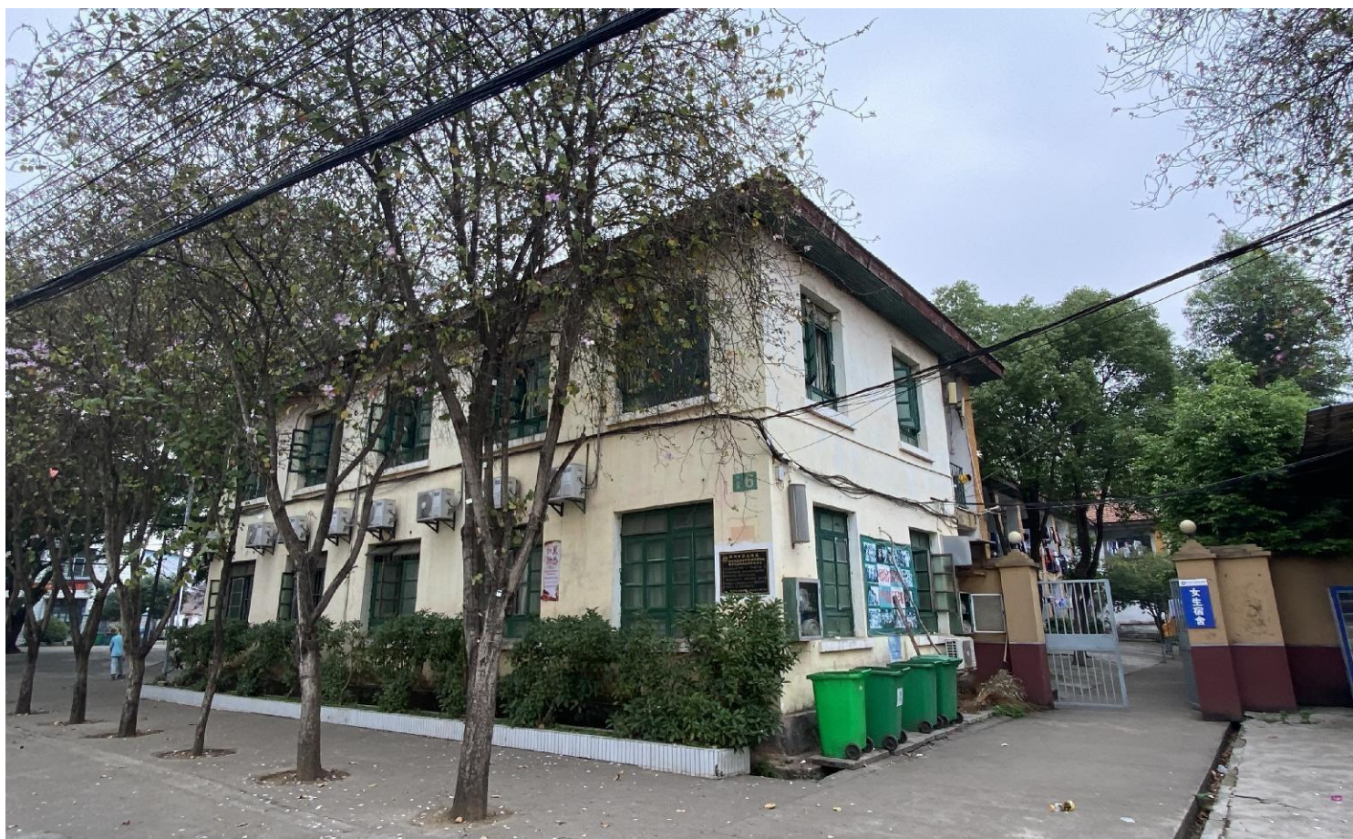
现状现状照片
