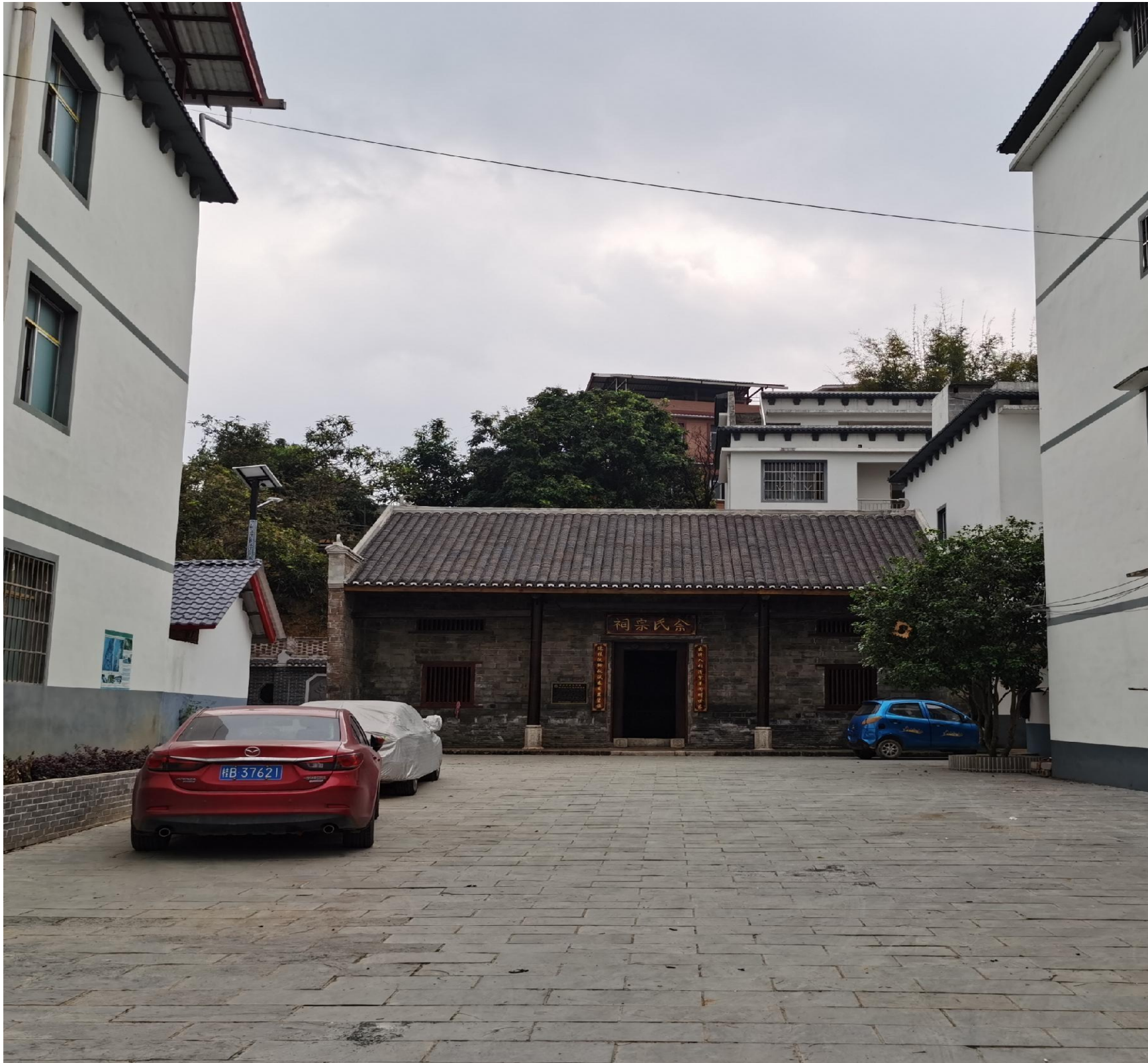
建筑现状照片
