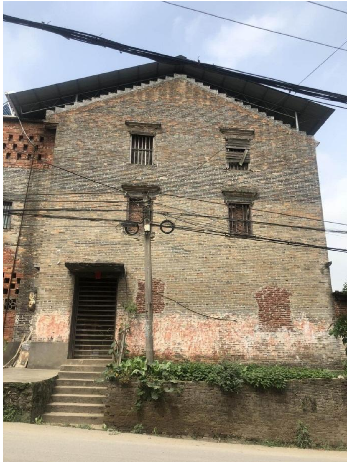
建筑现状照片
