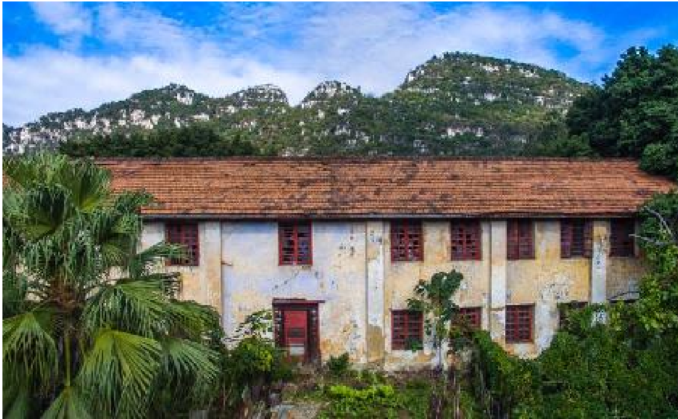
建筑现状照片
