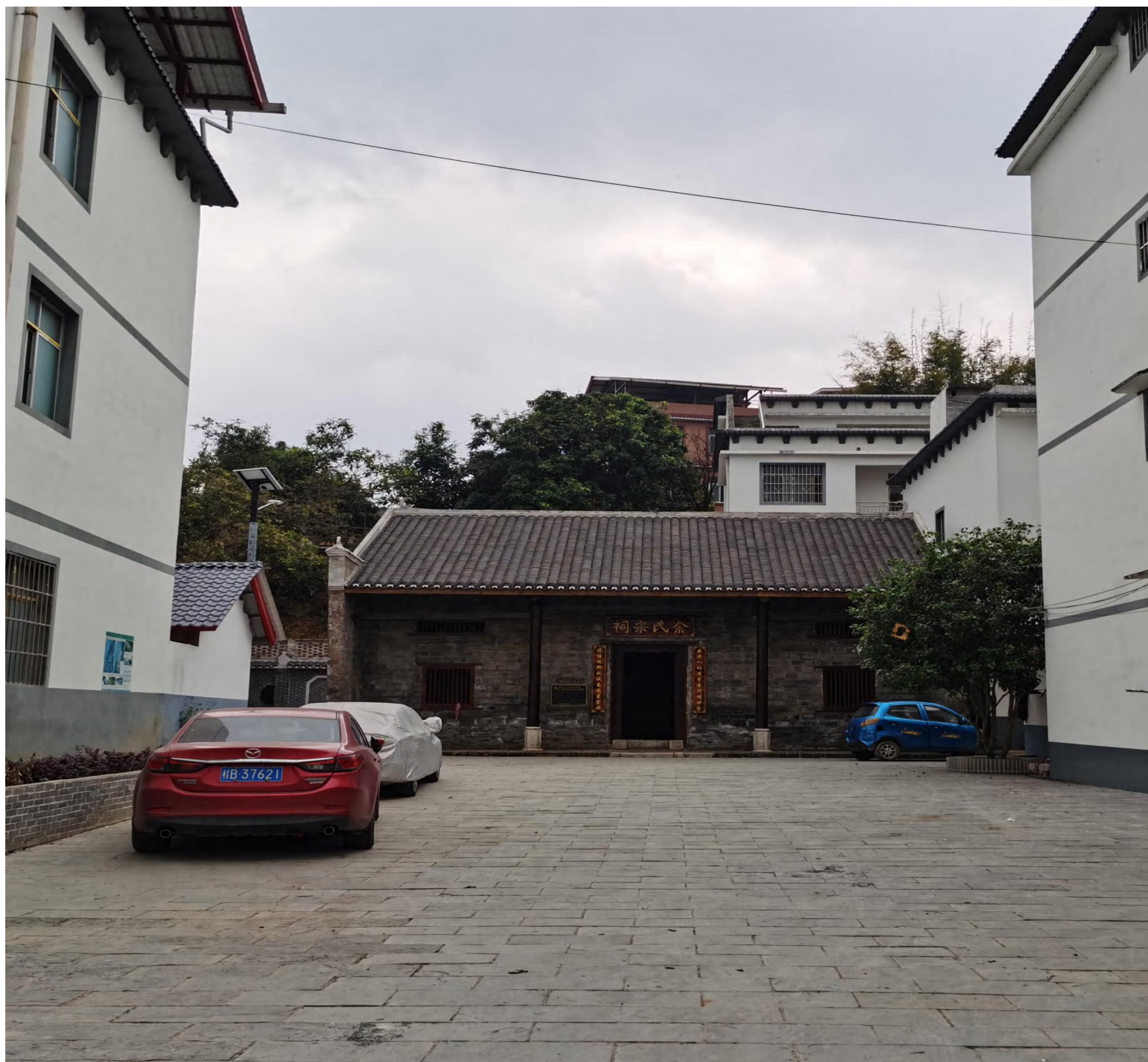
建筑现状照片
