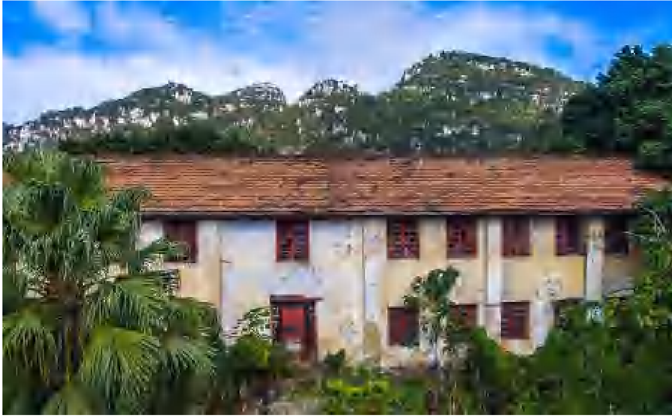
建筑现状照片
