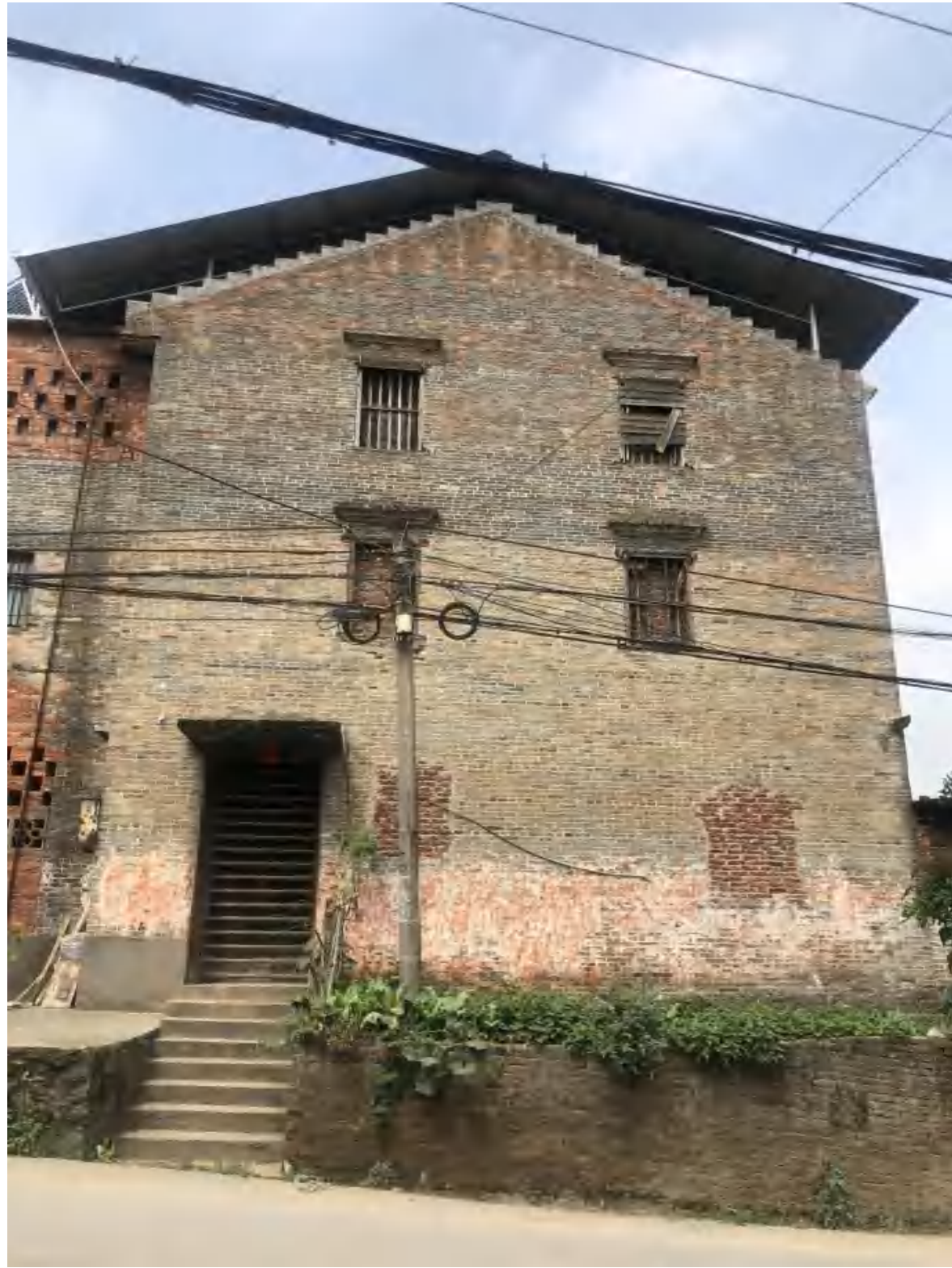
建筑现状照片
